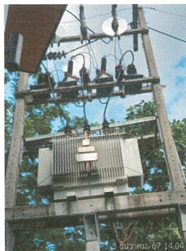
รูปภาพที่ 2.8 หม้อแปลงไฟฟ้า
