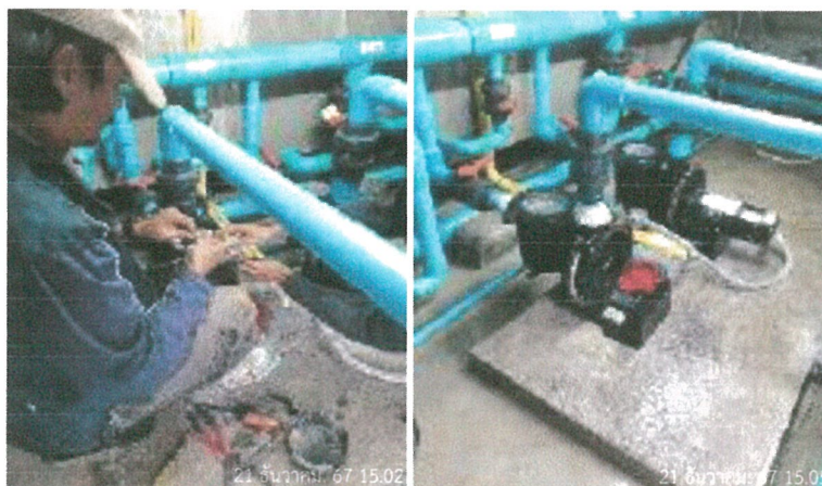
รูปภาพที่ 2.12 การตรวจสอบเส้นท่อน้ำและเครื่องสูบน้ำ
